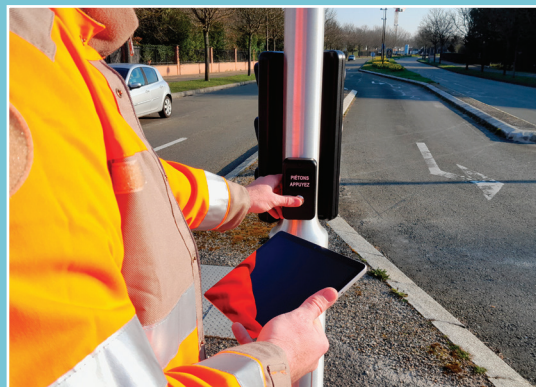
« Prendre le contrôleur en mains » Mise en service et maintenance à 1m des équipements et jusqu'à 80 m du contrôleur
